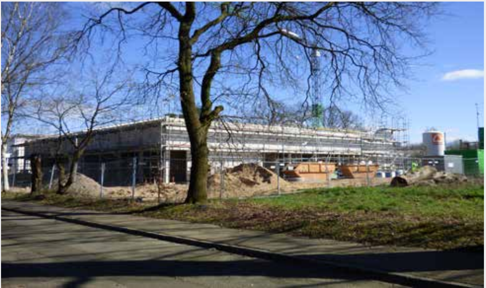
Baustelle Albertinenhospiz Norderstedt im März 2020
