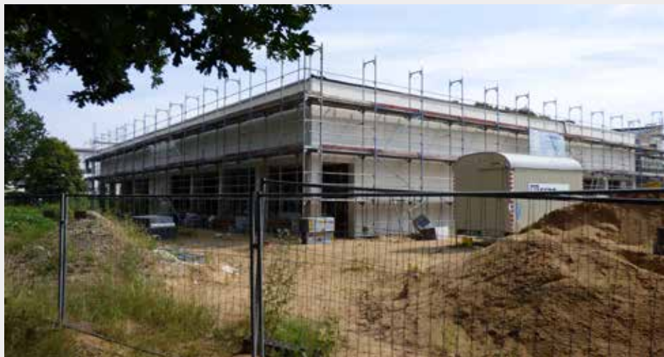
Baufortschritt im Juli 2020
